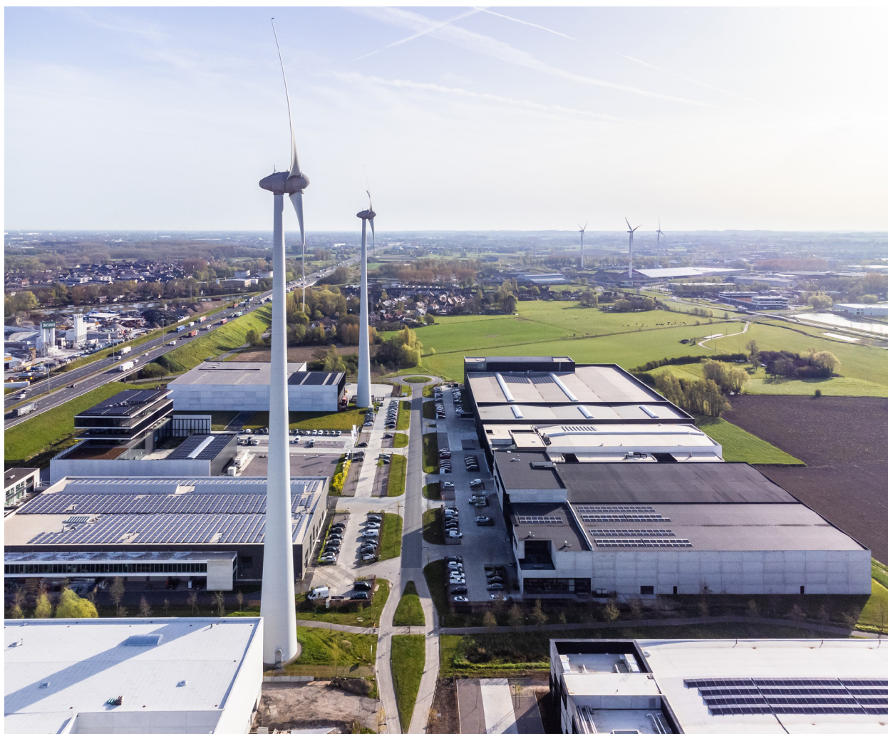
Vluchtfoto windturbines te Evolis
