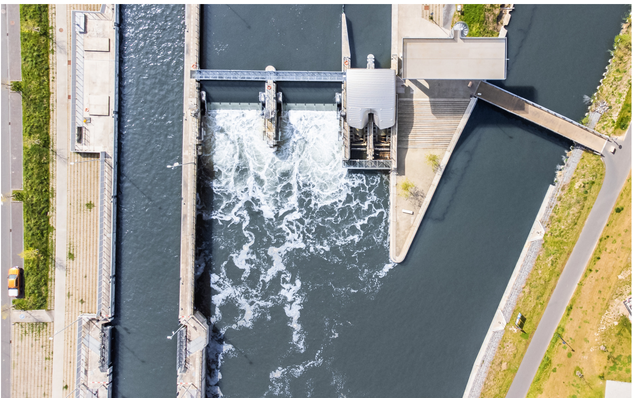
Sluis in de Leie te Harelbeke
