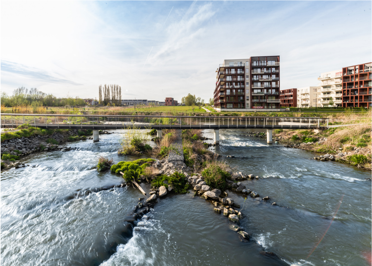
Vistrap aan de Leie ter hoogte van Sluis Harelbeke
