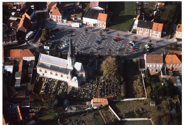
luchtfoto Bavikhove, voor de heraanleg
