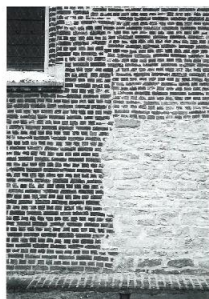
twee bouwfases: links metselwerk van 1872, rechts metselwerk van de verbrede zuidbeuk
