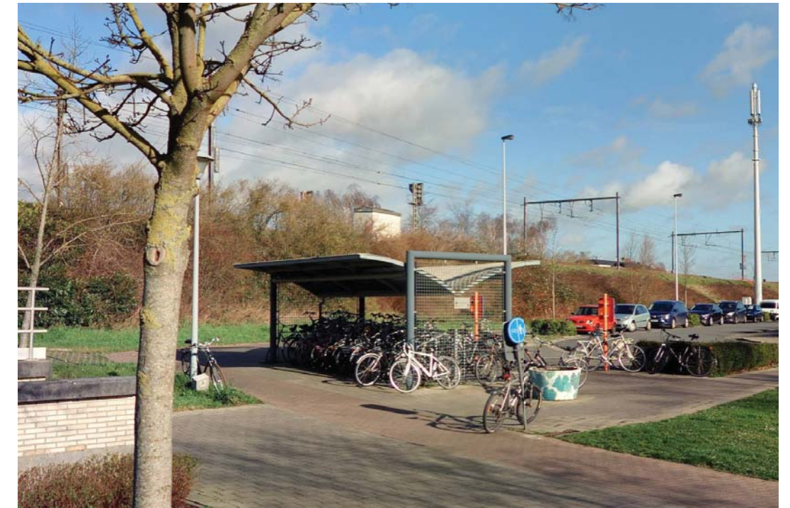
overdekte fietsenstalling aan het station harelbeke
