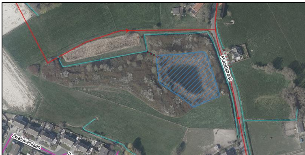
Figuur 33: Bufferbekkens in Muizelstraat vanuit de lucht.
