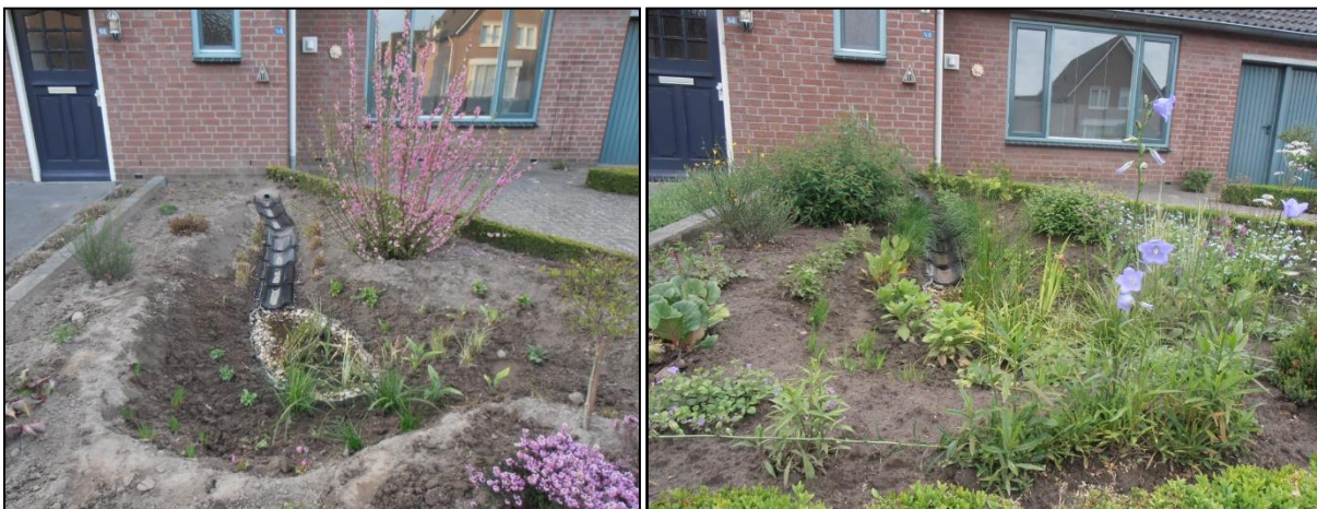
Figuur 79: Regenwater naar wadi in voortuin (links: aanleg wadi, rechts: wadi voltooid) (Van Eck, G., sd)
