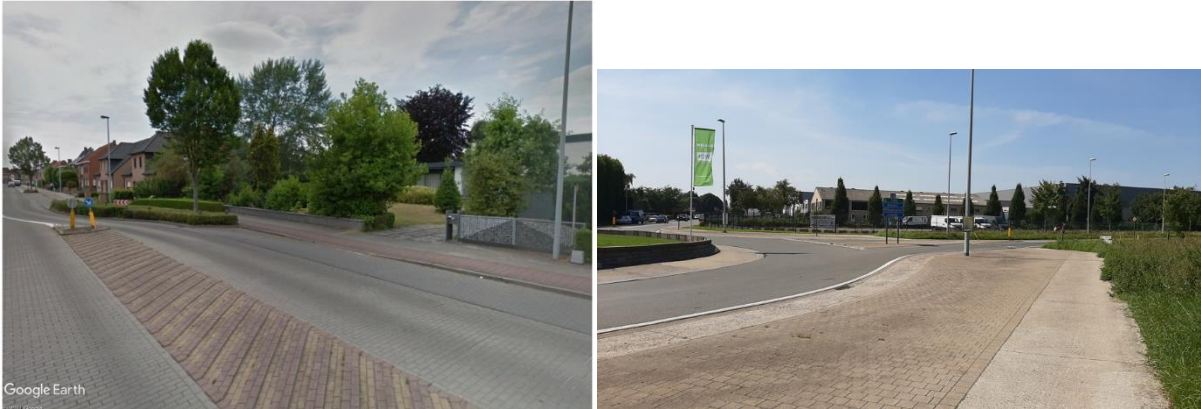
Figuur 74: Middenberm in de Jan Breydelstraat en een sterk verharde rotonde te Bavikhove (Google, sd)
