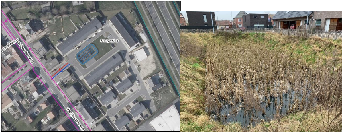
Figuur 35: Smeyershof bevat een wadi/bufferbekken in de binnentuin.
