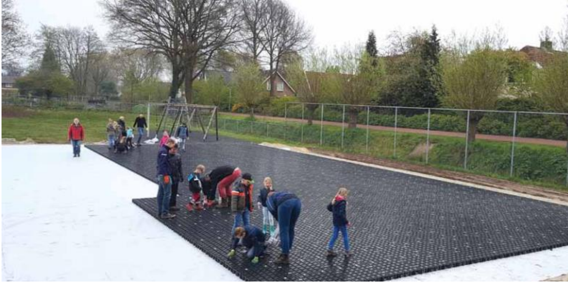
Figuur 125: Optie om water toch te kunnen laten infiltreren onder een sportveld. Met infiltratiekratten kan een zone voor water gemaakt worden zonder dat er water echt op het veld blijft staan.
