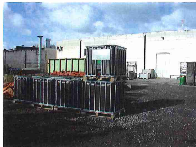
Foto 3: zicht op achterzijde constructieruimte
