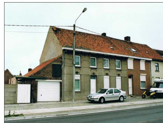
(6) Voormalige herberg de barrière / Brugsesteenweg 77
