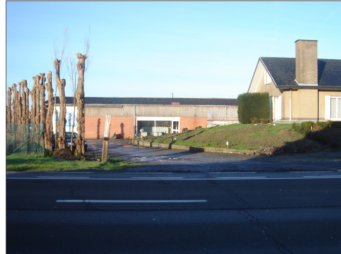
(5) De werkactiviteiten van 'Lepo Decoration' vinden plaats in de loods opgetrokken op achterliggende perceel. Langs de Brugsesteenweg werd de bedrijfswoning gebouwd.
