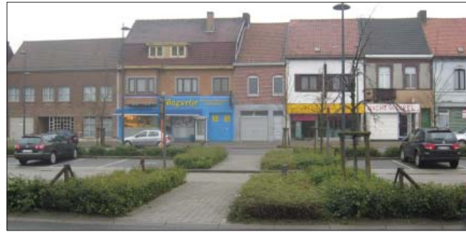
Zicht op Kortrijksestraat met ervoor de parkeerzone tussen de ontubbelde N43.
