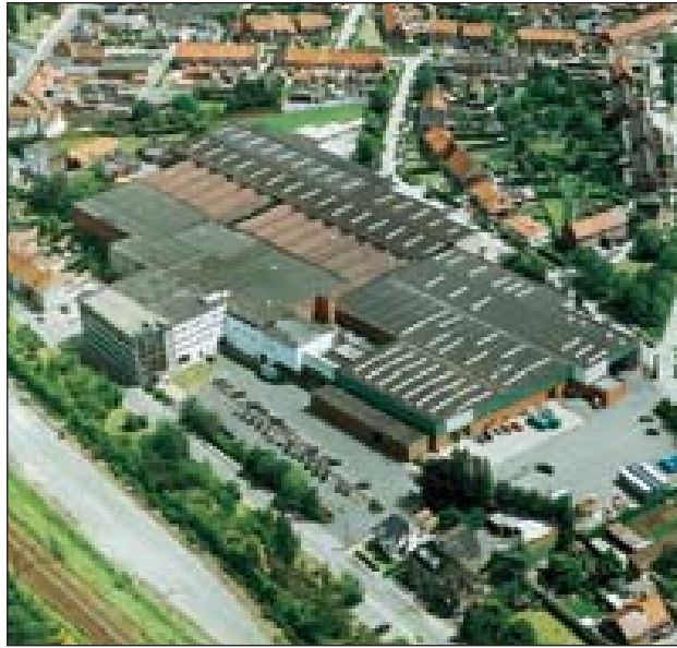
figuur 03: Vluchtfoto site Lano te Harelbeke
