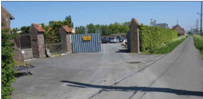
Zicht vanaf de Darmstraat op de ingang van de bedrijfssite.
