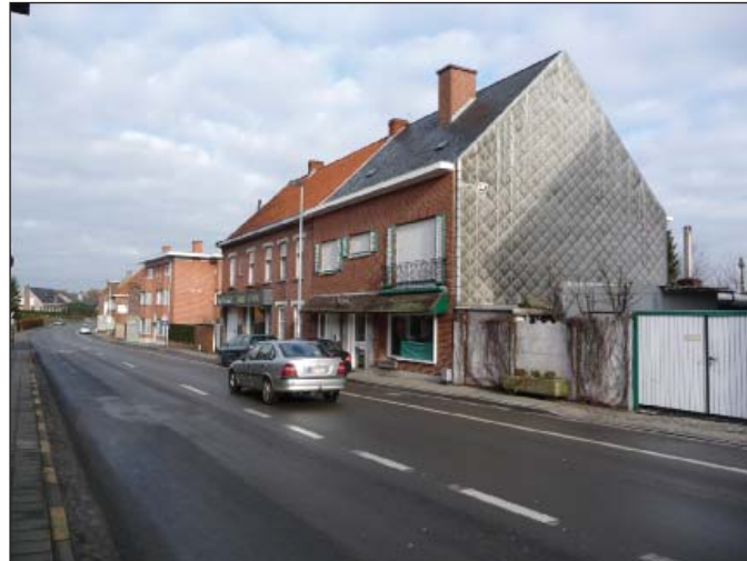
Ook de Vlietstraat wordt gedomineerd door aangesloten bebouwing van twee bouwlagen met een hellend dak. Nabij het dorpsplein vinden we een bakker en een slagerij. De Vlietstraat werd recent ook heraangelegd. Het nieuwe profiel (zie foto hiernaast) met ruime voetpaden en fietsuggestiestroken (waar de rijstroken minder breed tonen) geven de straat een verblijvend karakter.
