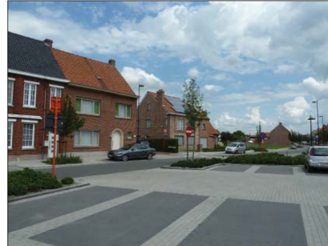
Iets verder in de straat wordt het plein afgebouwd met aangesloten woningen van twee bouwlagen hoog. Deze bouwhoogte is maatgevend voor alle historische dorpsstraten van Bavikhove.
