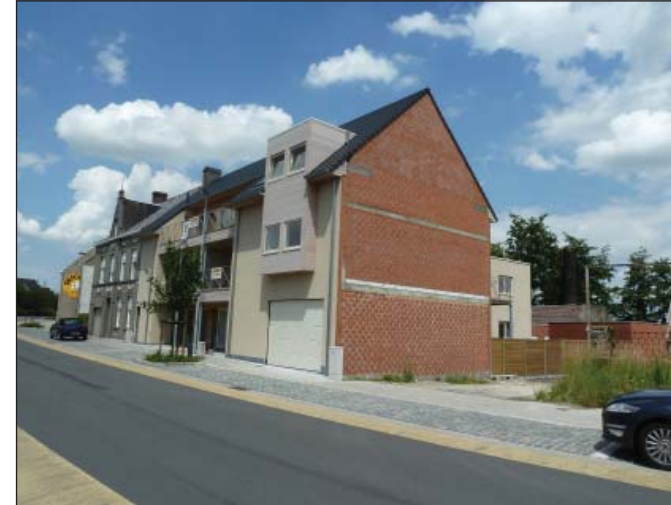
Halfweg de Vlietstraat vervangt een nieuwbouw appartementencomplex een voormalige vlasschuur. Deze vlasschuur was opgenomen in de inventaris bouwkundig erfgoed, samen met de aanpalende woning. De erfgoedwaarde van de schuur was te beperkt, waardoor een afbraak te motiveren was.
