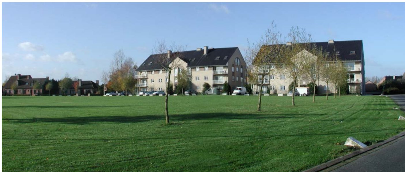
↓ Foto 14: Zicht op het Kollegeplein en de omliggende bebouwing
