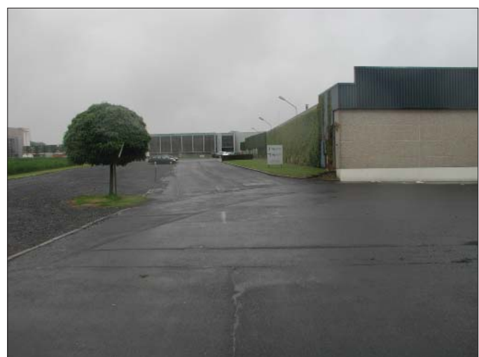
foto 6: toegang en parking hoofdgebouw
