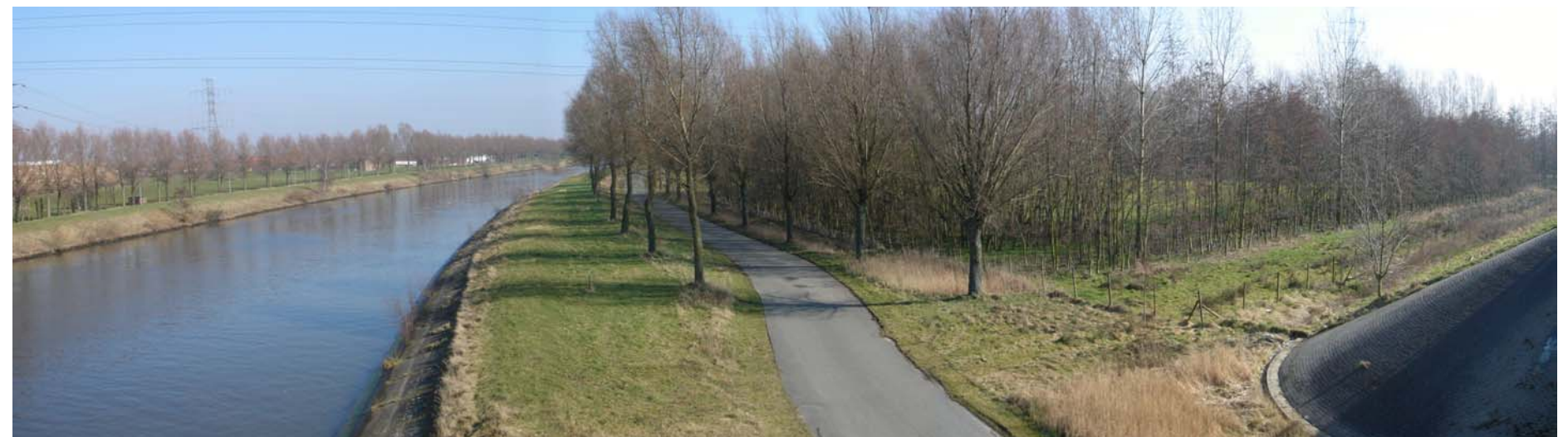
Zuidelijke oever van de Leie: jaagpad en beplanting
