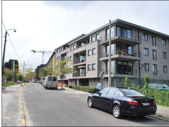
Een reeds gerealiseerd appartementenproject langs de Ballingenweg (eenrichtingsverkeer).
