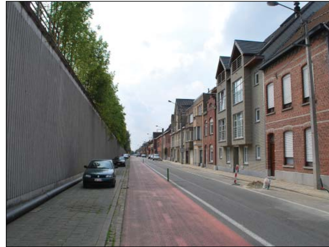
De zuidwestelijke grens van het plangebied is de Tuinstraat. Langs de ene zijde van deze eenrichtingsweg de betonnen wand waarop de spoorlijn Kortrijk-Gent is gerealiseerd; langs de andere zijde voornamelijk woonbebouwing.
