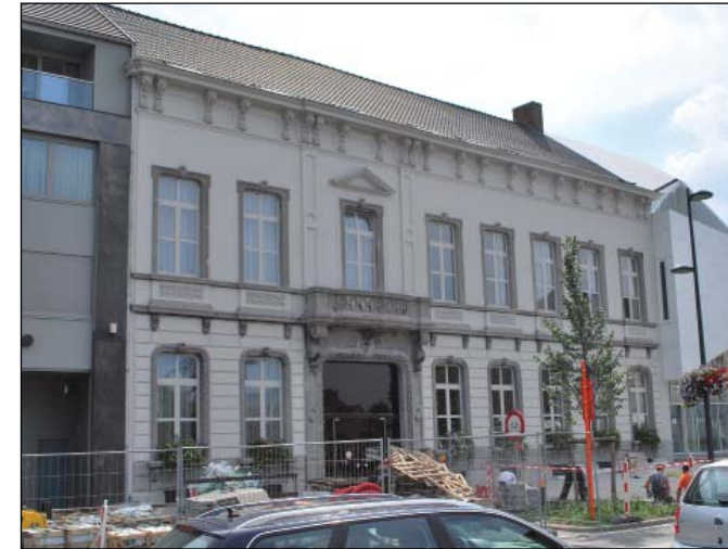
Het stadhuis bestaat uit een historisch neo-klassiek gebouw, met langs de rechterzijde een hedendaagse toevoeging.
