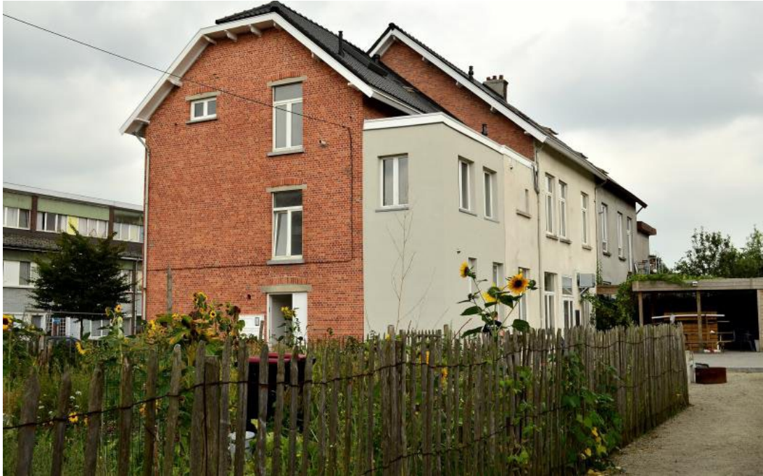
AANBOUW EN GEVELRENOVATIE LANGS DE ACHTERZIJDE VAN EEN VOORMALIG POSTGEBOUW, DUIDELIJK ONDERSCHIED TUSSEN WAT OUD EN NIEUW IS
