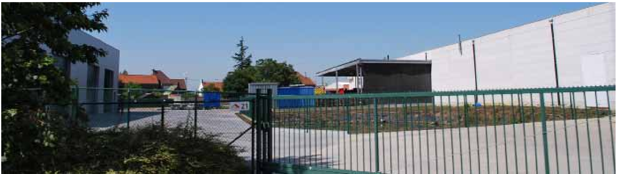
SITE VANASSCHE ACHTERLIGGENDE LOODSEN VANOP DE GENTSESTRAAT
