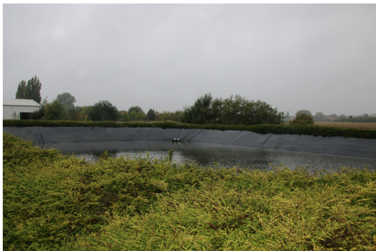
HET WATERBUFFER DAT IN DE NOORDELIJKE HOEK VAN HET PLANGEBIED IS GELEGEN
